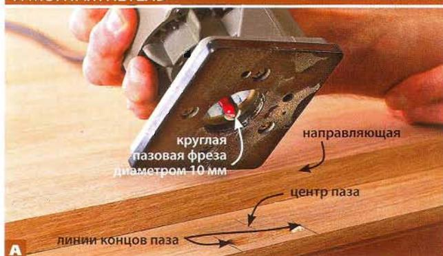
Установите с помощью прямой направляющей центр круглой пазовой фрезы диаметром 10 мм над осевой линией разметки и выберите пазы-желобки для петельных цилиндров.
